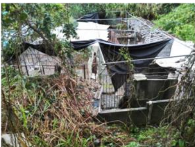
修葺前台风将基地的顶棚尽数毁坏，不能再为狗狗遮风避雨
